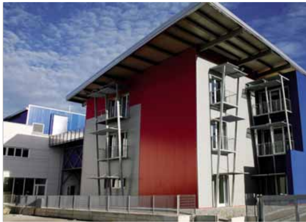
Il consumo di energia più basso è garantito da una CasaClima Oro che richiede 10 KiloWattora per metro quadro l'anno
